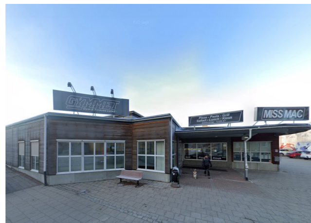
Angränsande fastighet, Gymmet Luleå & MissMac restaurang
