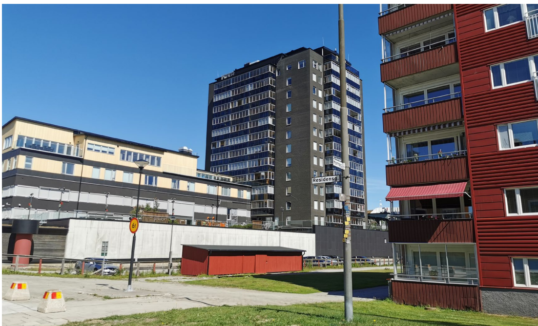
Figur 17: Bild från området. Delar av kvarteret Hägern, bland annat det 45 meter höga punkthuset nordöst om planområdet.
