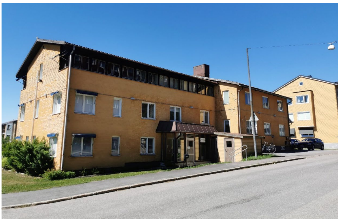
Figur 2: Befintlig kontorsbyggnad på fastigheten Fjärilen 3.
