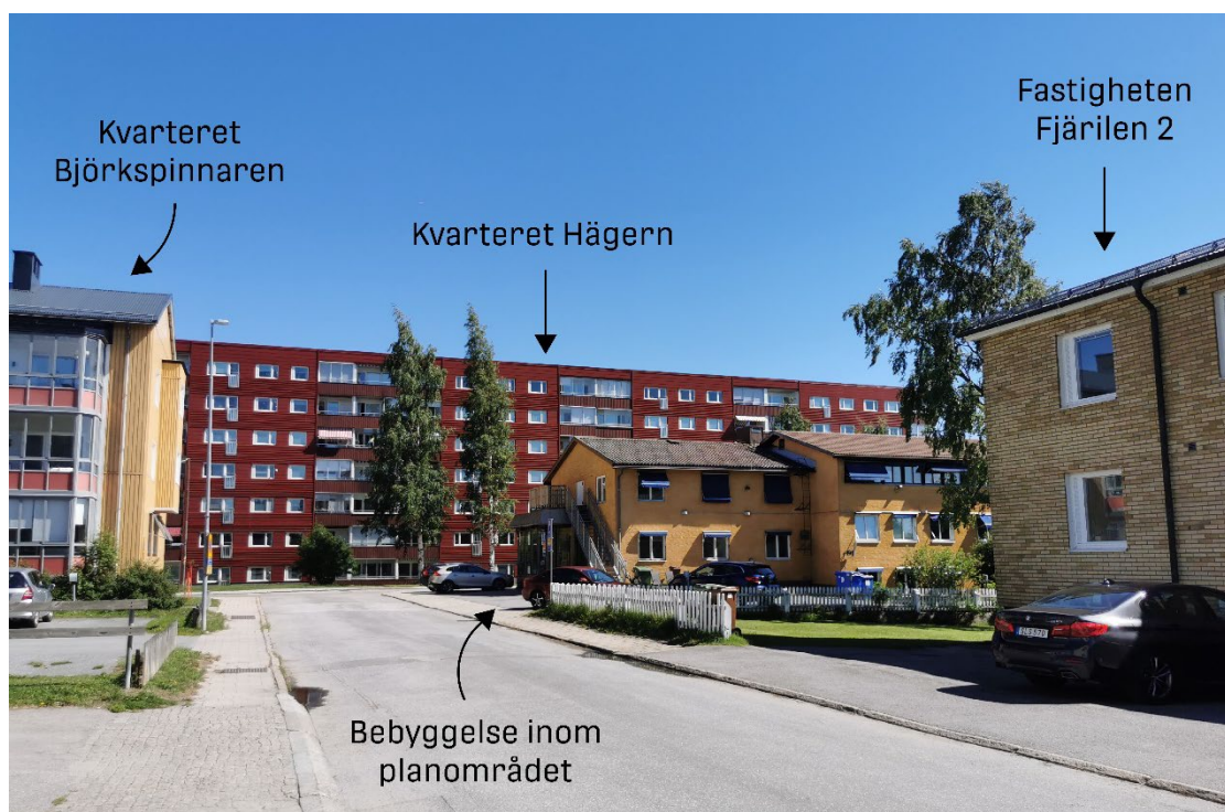
Figur 16: Bild från området. I bakgrunden syns delar av kvarteret Hägern (röd bebyggelse). Till vänster i bild syns kvarteret Björkspinnaren och till höger i bild syns delar av bebyggelsen på fastigheten Fjärilen 2.
